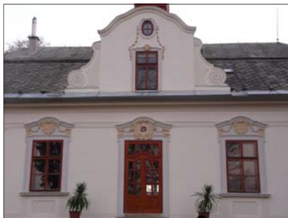
63 Severní průčelí po rekonstrukci
