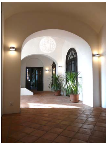
43 Vstupní hala po rekonstrukci
