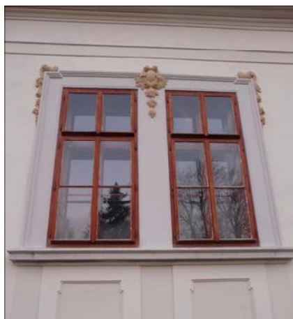
67 Soustředěná okna po rekonstrukci
