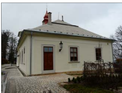
59 Východní pohled na zámek po rekonstrukci
