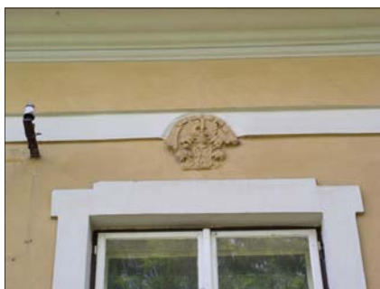
64 Detail erbu před rekonstrukcí
