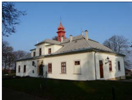
51 Jihovýchodní pohled na zámek po rekonstrukci
