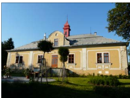
54 Severní pohled na zámek před rekonstrukcí
