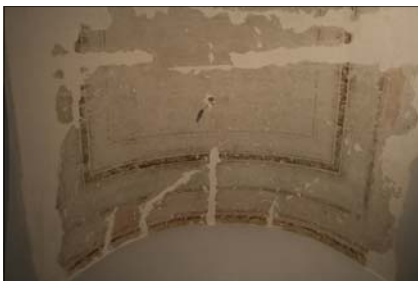
9 Stav během hloubkové injektáže a strukturálního zpevnění omítek
