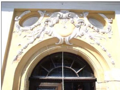
44 Detail portálu hlavního vstupu před rekonstrukcí
