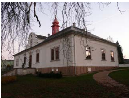
57 Severozápadní pohled na zámek po rekonstrukci
