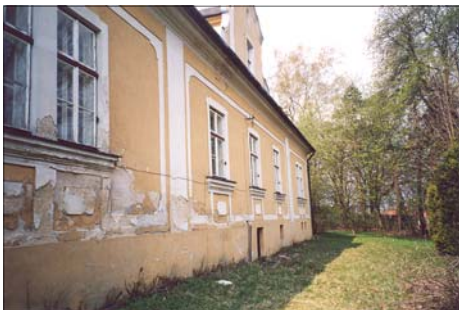
4 Průčelí před opravou, detail druhotných architektonických prvků, stav 2003, foto J. Štáblová
