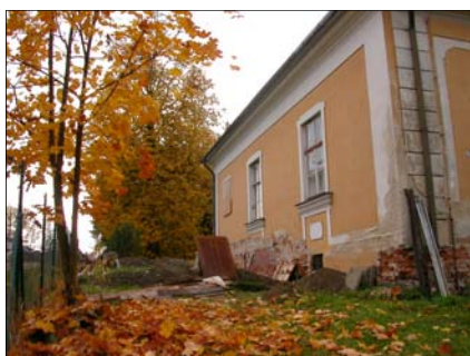
58 Východní pohled na zámek před rekonstrukcí
