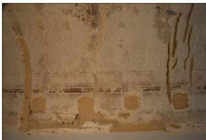
7, 8 Stav během odstranění starší el. instalace a zbrúšení nevhodných vysprávek, zajištění
