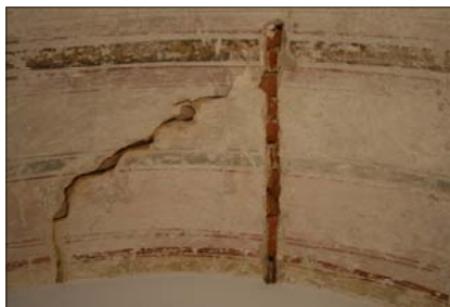
7, 8 Stav během odstranění starší el. instalace a zbrúšení nevhodných vysprávek, zajištění
