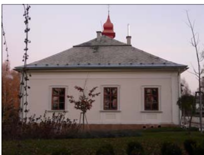
Obr. 61 Západní pohled na zámek po rekonstrukci
