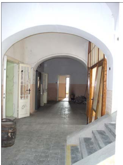
42 Vstupní hala před rekonstrukcí
