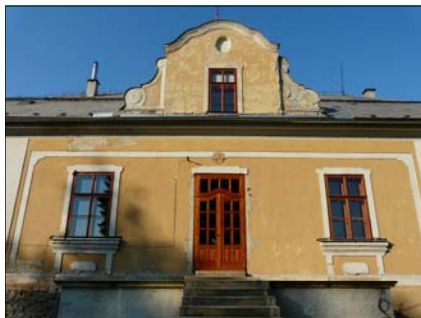
62 Severní průčelí před rekonstrukcí
