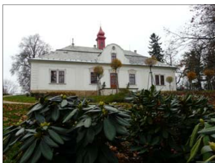
55 Severní pohled na zámek po rekonstrukci
