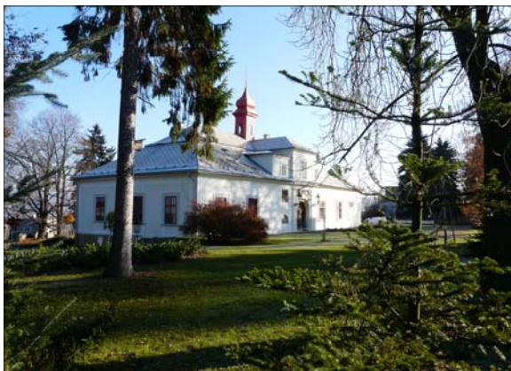
10 Zábřeh, zámek Skalička, celkový pohled na dvorní a boční průčelí po opravě, stav 2012
