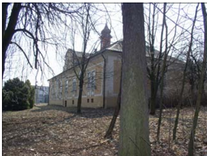
56 Severozápadní pohled na zámek před rekonstrukcí
