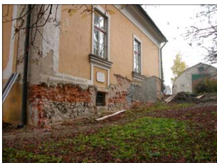
Obr. 60 Západní pohled na zámek před rekonstrukcí
