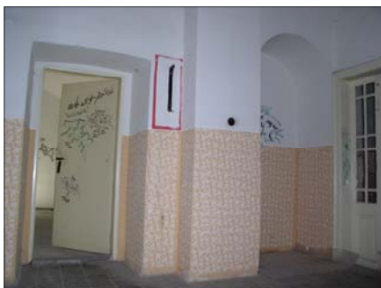
13, 15, 17 Kavárna před rekonstrukcí
