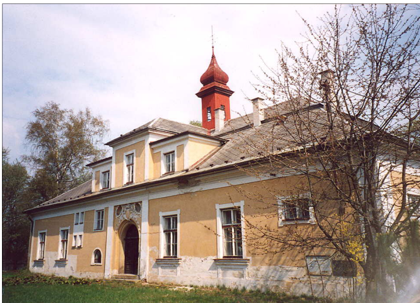
1 Zábřeh, zámek Skalička, celkový pohled na jižní dvorní průčelí před opravou, stav 2003, (foto J. Štáblová)
