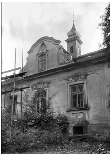
5 Severní zahradní průčelí, detail původního členění, stav 1950, zapůjčeno z archivu ÚP NPÚ
