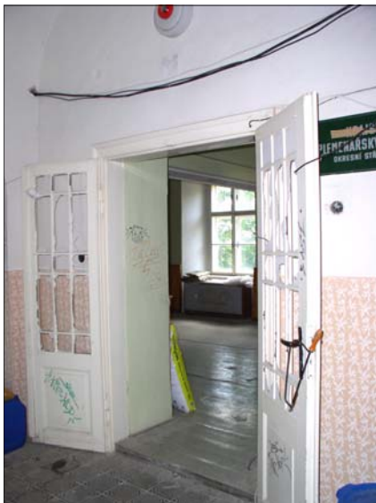
40 Vstup do galerie z haly před rekonstrukcí
