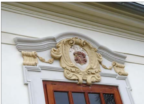
9 Severní zahradní průčelí po opravě, detail okenní šambrány s nadokenní římsou, štukovou kartuší a druhotně osazeným erbem, stav 2012, foto J. Štáblová
