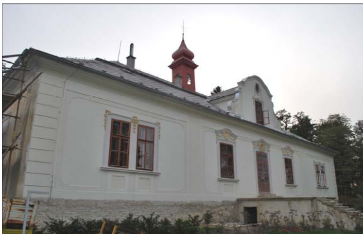
8 Severní fasáda zámku po rekonstrukci novobarokní štukové výzdoby a po nátěru
