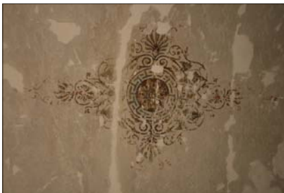
9 Stav během hloubkové injektáže a strukturálního zpevnění omítek
